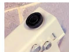
El perno de ajuste proporciona hasta 5 grados de corrección
