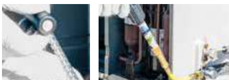
Inyección de tinte girando la manija.
