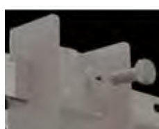
4. Fixation de la barre et des bras verticaux avec vis TH CL.8.8
