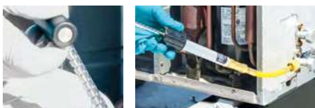
Wprowadzanie uszczelnacza za pomocą dozownika.
