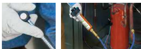
Wprowadzanie barwnika za pomocą dozownika.
