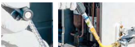
Wprowadzanie barwnika za pomocą dozownika
